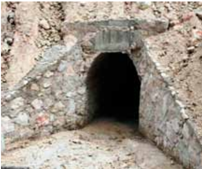
Entradas en ambos lados de la alcantarilla
