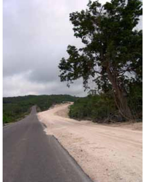
Tramo carretero entre Escárcega y Xpujil. Foto: Edmundo Huerta
