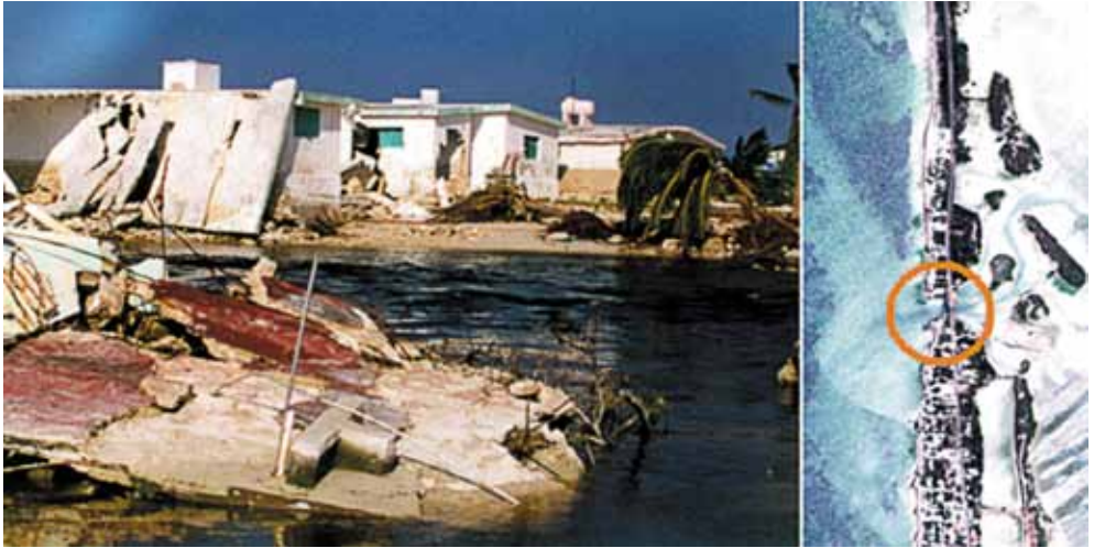
Figura 2. Rupturas de la isla de barrera en el tramo San Crisanto-Dzilam de Bravo.
