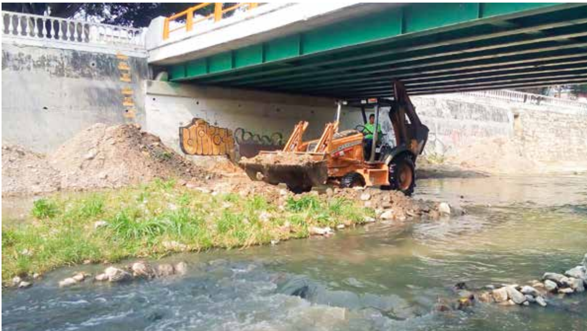
Figura 2. Trabajos de limpieza en el cauce del río Sabinal, antes de la época de lluvias. Foto: CENAPRED
